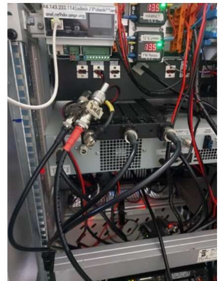
3dB-Koppler zur Aufteilung der RX-Signale
