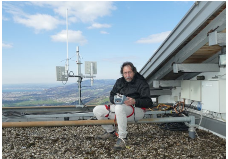
Peter DC2ZO bei der Messung am Dach. Die schadhafte Antenne ist die dritte von links (70cm Sirio GP 430 LB N) Foto: Herbert OE9HRV
