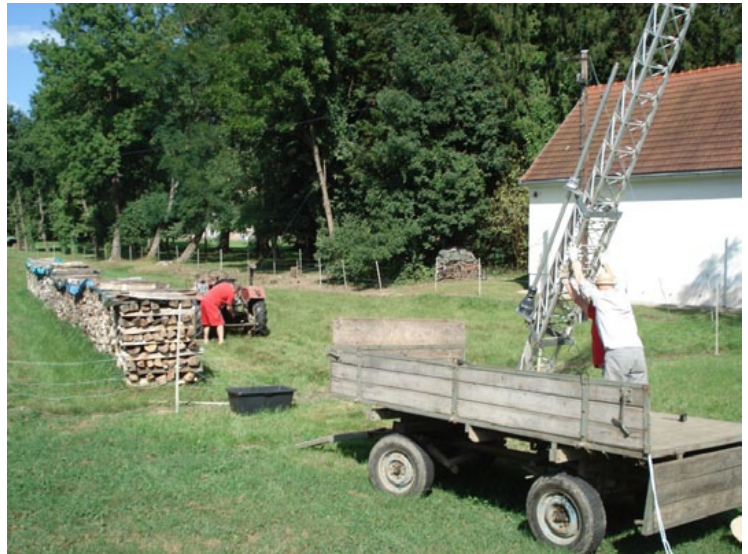
Aufstellen des 12 m-Alumasten: OE6FNG Werner dreht die Winde
