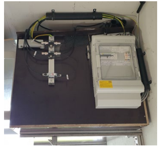
Stromversorgung mit Wiedereinschaltautomat, Potentialausgleich und Überspannungsschutz
