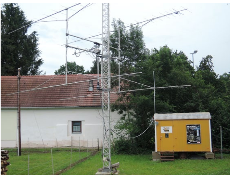
Die gesamte EME-Anlage – im Ruhezustand stehen die Antennen auf „Halbmast“ um etwaige Sturmschäden zu vermeiden.
