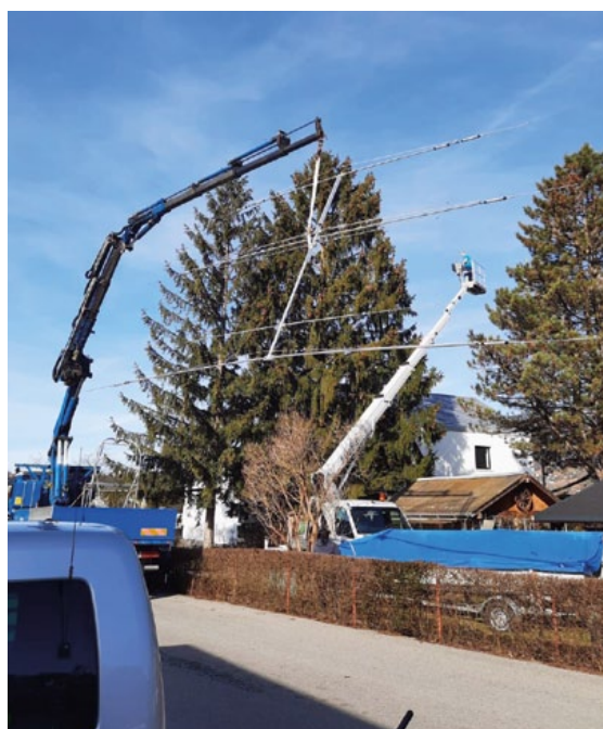
oben und rechts: Helfer, Steiger und Kran bei der Montage der Antenne
