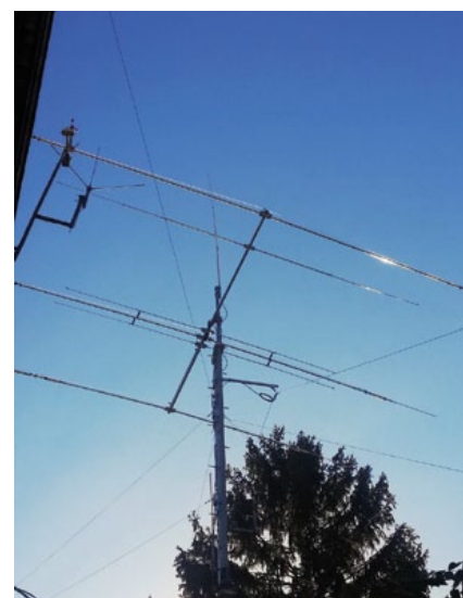
die montierte Antennenanlage
