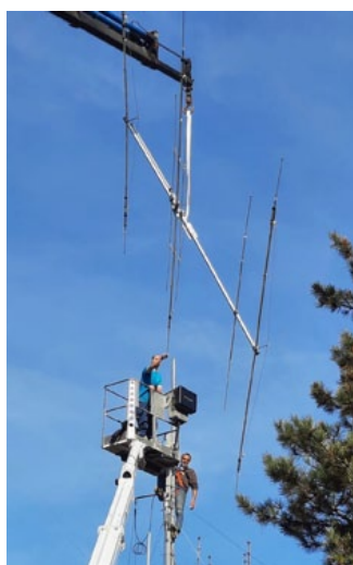
oben und rechts: Helfer, Steiger und Kran bei der Montage der Antenne
