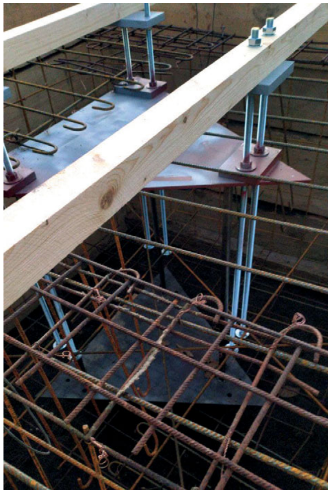
rechts: Armierungs- korb aus Baustahl und eingelagerter dreiecks- förmiger Befestigungs- anker
