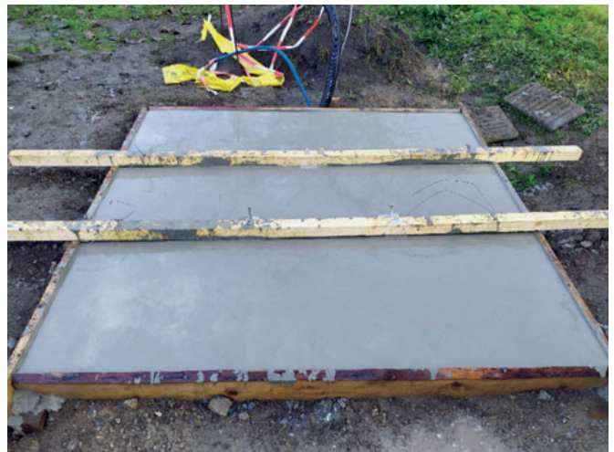
Das Fundament frisch nach dem Betonieren. Im Hintergrund das Zuleitungsrohr und der Erdungsanschluss (16 mm 2 Al)
