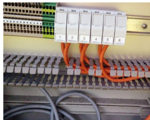
Antennenanschlüsse (links) und Netzwerkanchlüsse im Außenschrank (unten)
