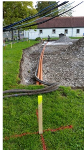
oben: Grabungsarbeiten und Verrohrung OE9XRV
