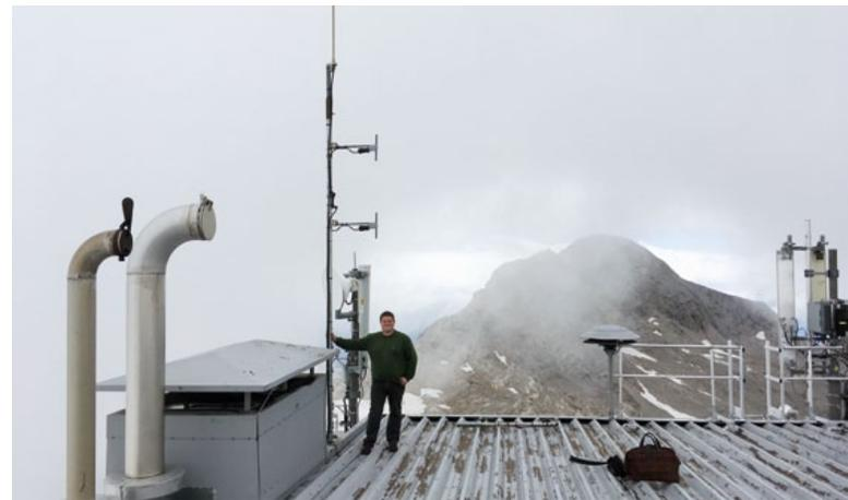
OE5LML mit dem fertig montierten Antennenmast. Die beiden Kathrein-Dipole fungieren als Sendeantenne.
