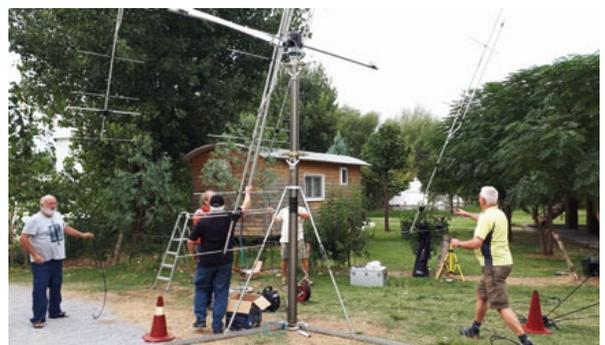
Aufbau der 2 m- EME- Antennenanlage am Pneumatikmasten
