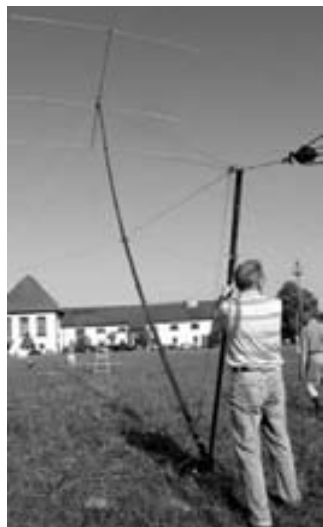
Der 17-m-Mast biegt sich beim Aufstellen.
